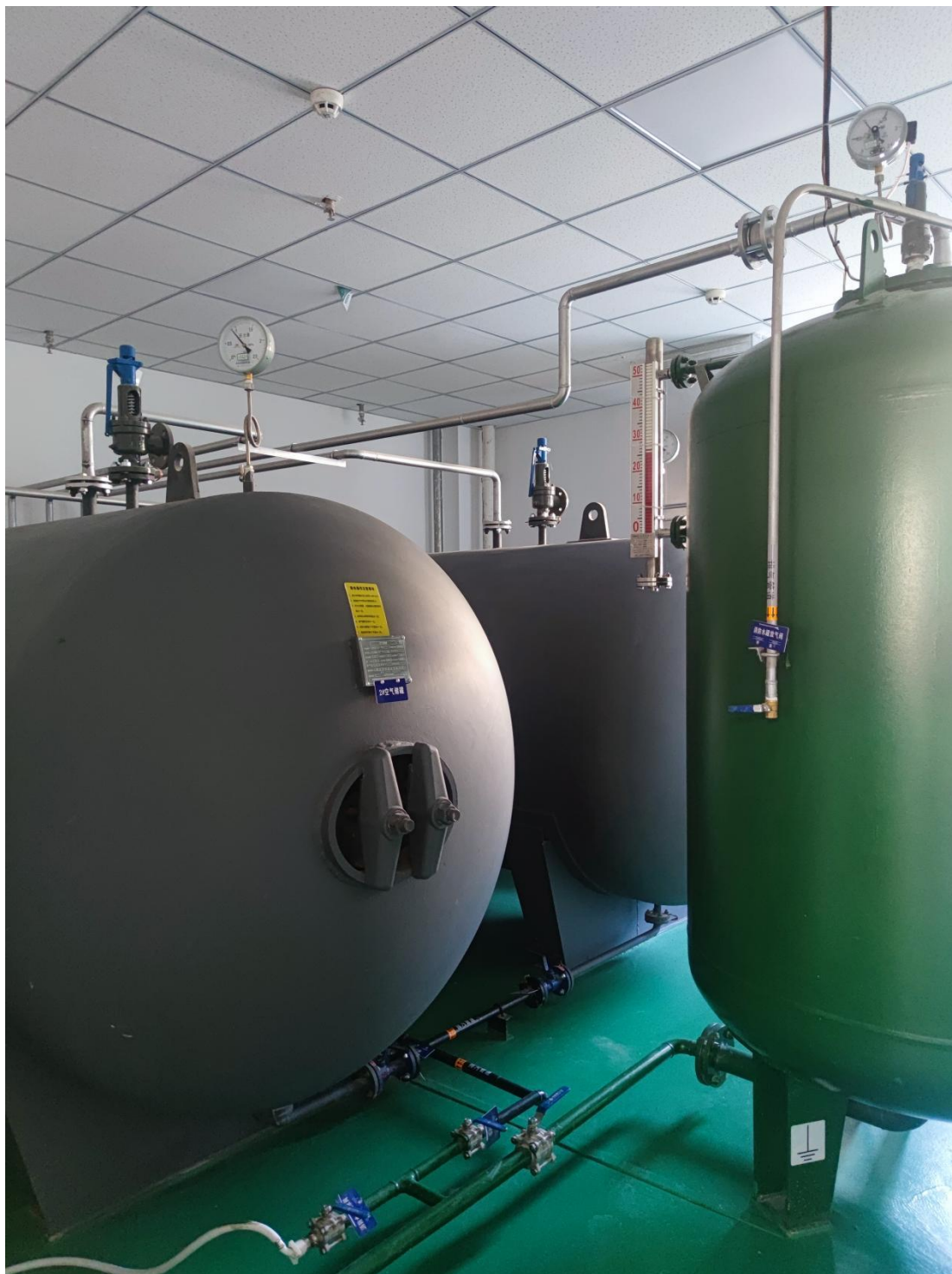
图 2 - 库尔勒市第二人民医院高压氧舱空气储罐现场调研照片
