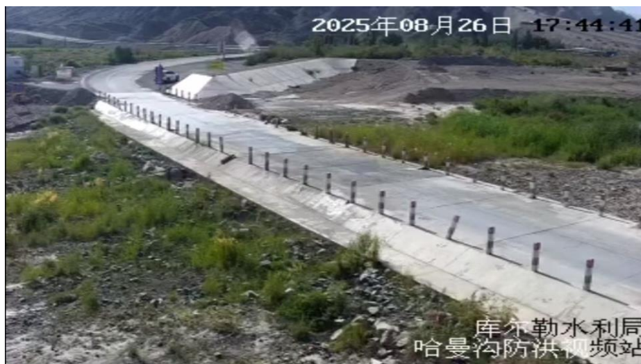
图 1.5-1 哈满沟过水路面
